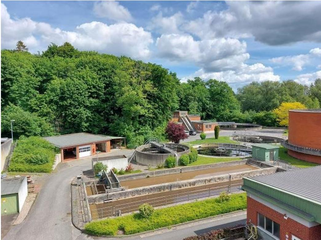
Abbildung A2. 1: Blick auf die Vorklärung, das Bio-P-Becken und die Becken der Nachklärung.
